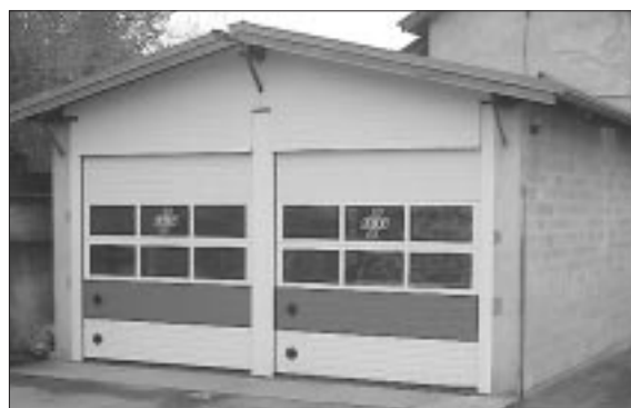
LA NUOVA AUTORIMESSA DEGLI AUTOMEZZI SOS DOPO I LAVORI DI SOSTITUZIONE DEL TETTO E DEI PORTONI D'INGRESSO
